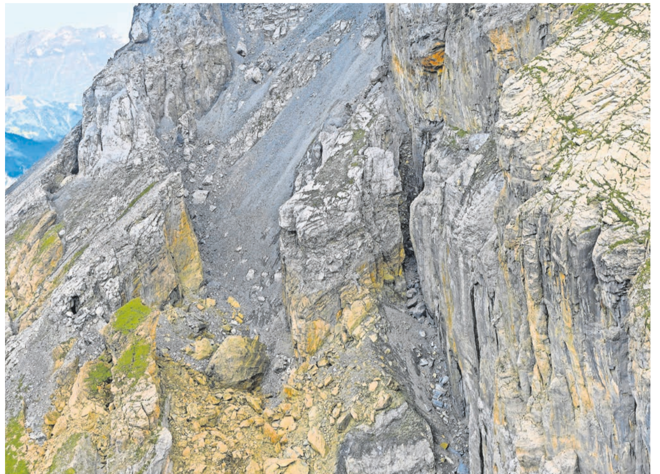
Verschiebungsmessungen im Reusstal zeigen signifikante geologische Bewegungen im Gebiet des Chli Windgällen. Die Daten dienen als Grundlage für das Überwachungskonzept der SBB auf der Nord-Süd-Achse. FOTO: SIMON WEGMÜLLER
